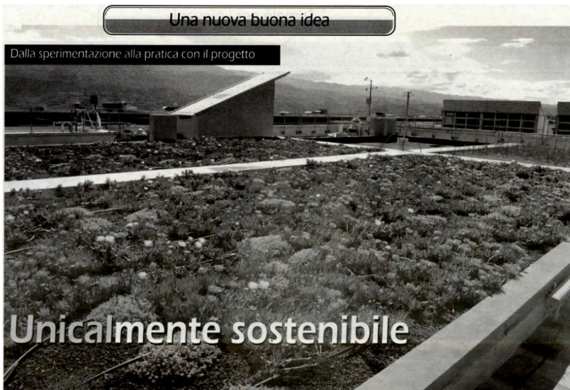
*Ultime novità nel drenaggio urbano legato alla realizzazione di servizi di gestione sostenibile per il ciclo acqua-energia caratterizzato dalla creazione di un tetto verde su uno dei cubi dell'area del complesso strutturale della ex*
