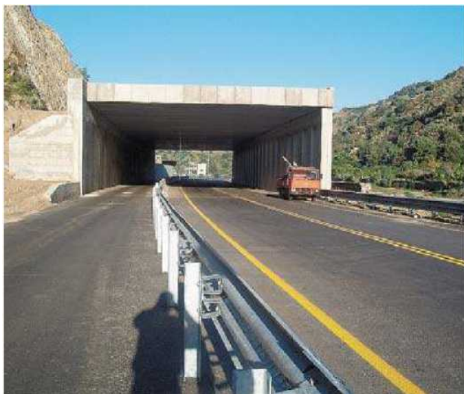
La galleria artificiale della Gallico-Gambarie
