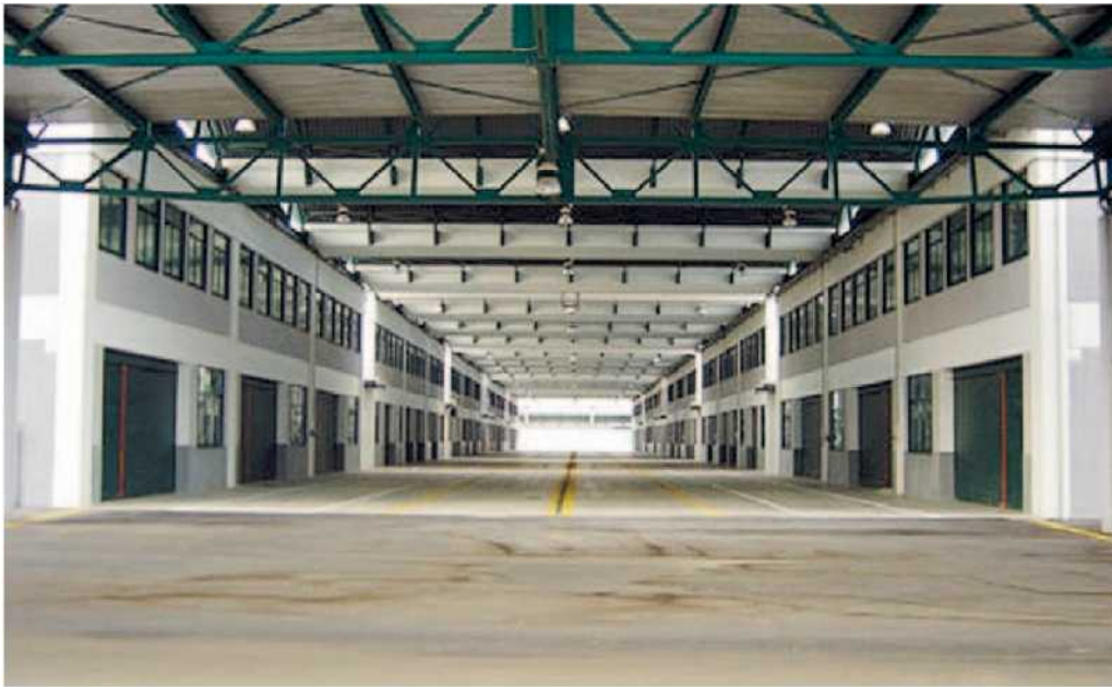
La struttura del Comac, a Montalto
