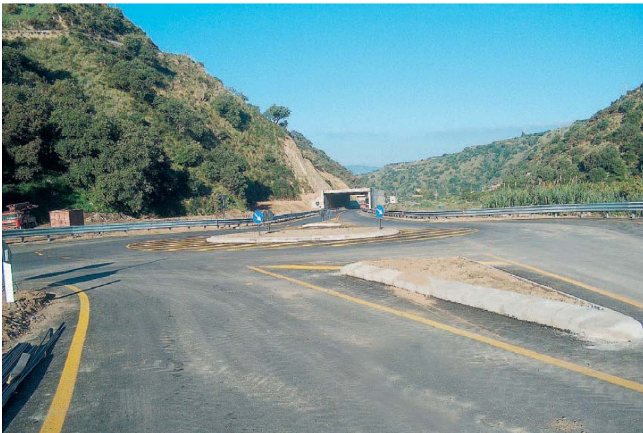
Un tratto della Gallico-Gambarie già ultimato. Il terzo e ultimo lotto sarà realizzato con i fondi comunitari 2007-2013
